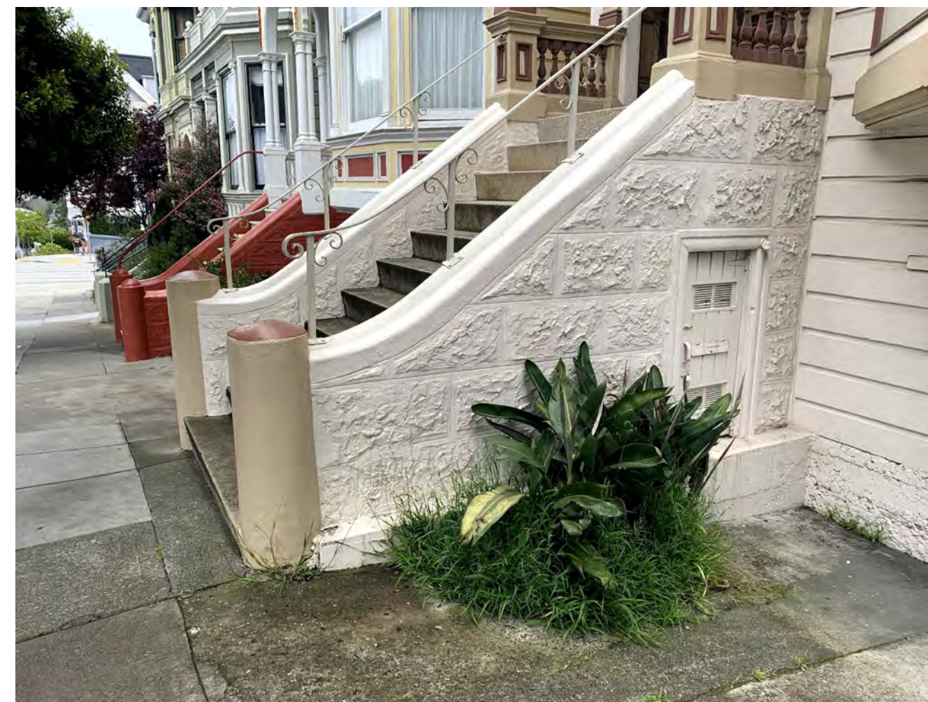
EXISTING FRONT STAIR 4 N.T.S.
